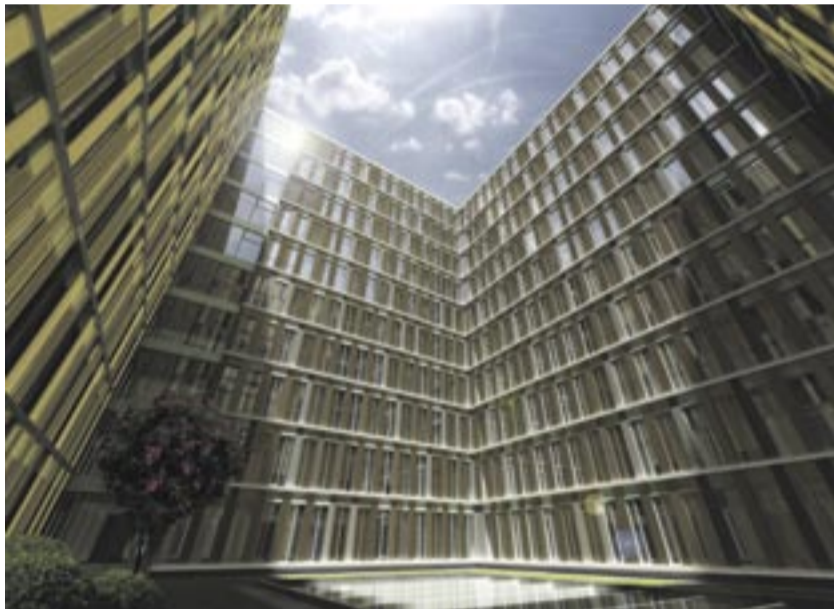
Insgesamt 21 000 Quadratmeter Bruttogeschossfläche oberirdisch entwickelt Hochtief mit ViCon beim Großprojekt Laimer Würfel in München. Fotos: Hochtief
